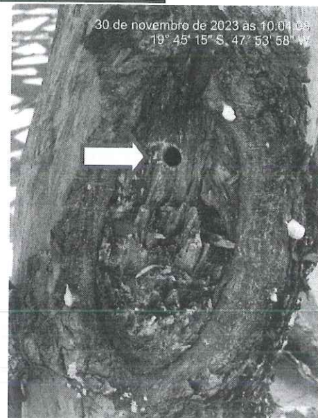
Figura 6: Perfuração no tronco do chorão.
