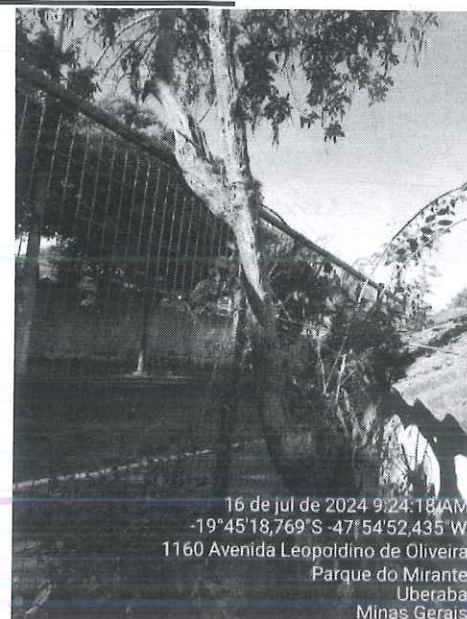
Figura 3: Ipê de jardim comprometido, indicado para supressão.
