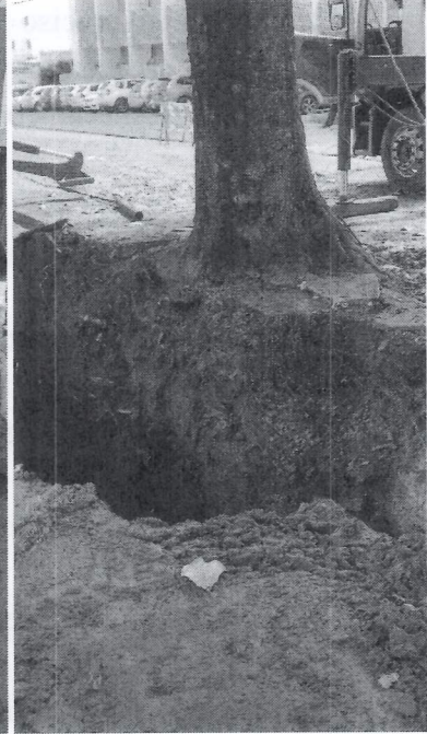
Da esquerda para a direita: vala aberta para substituição da tubulação, emprego de caminhão guincho para estabilizar a árvore durante a manobra. da via. Fonte: LIMA, Carlos Alberto Rodrigues/2024.
