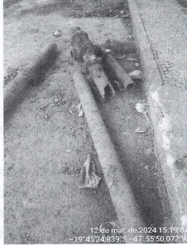
Da esquerda para a direita: equipamento empregado na secção das raízes, tubulação substituída e extensão da área dos dois lados da via. Fonte: SEMAM/2024.
