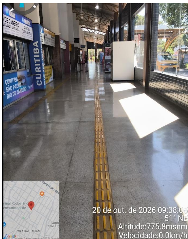
Pista tátil e piso limpo na vistoria
