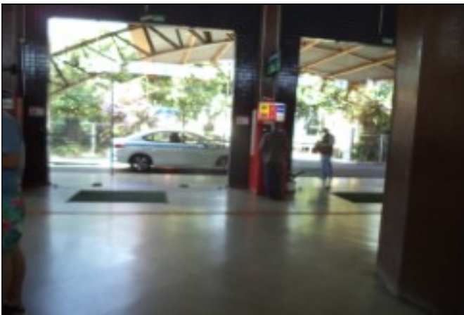
Parte interna bem conservada, limpa.
