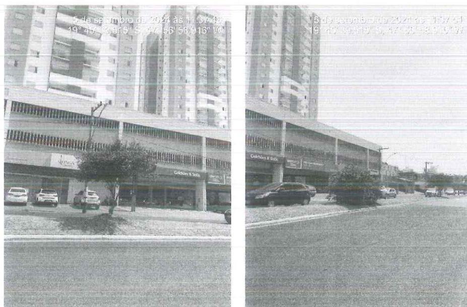
Figura 1: Vista da pitangueira e da clúsia alocadas no canteiro central da via.
