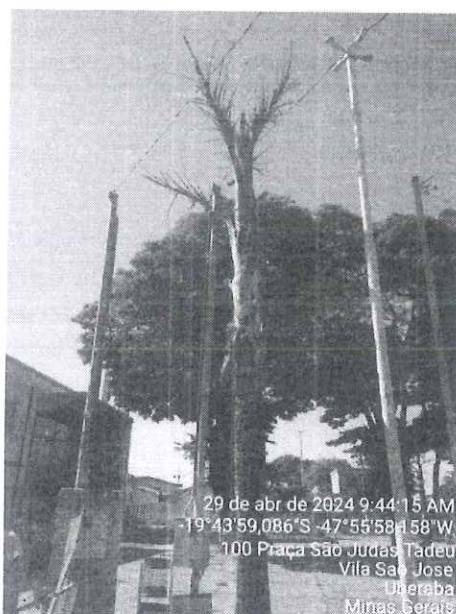
Figura 2: Uma palmeira em final de ciclo, indicadas para desmonte.
